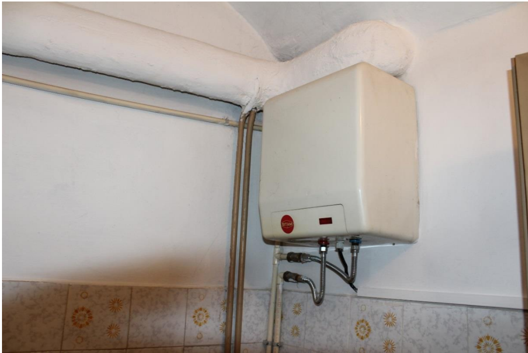
Boiler elettrico presente al piano terra
