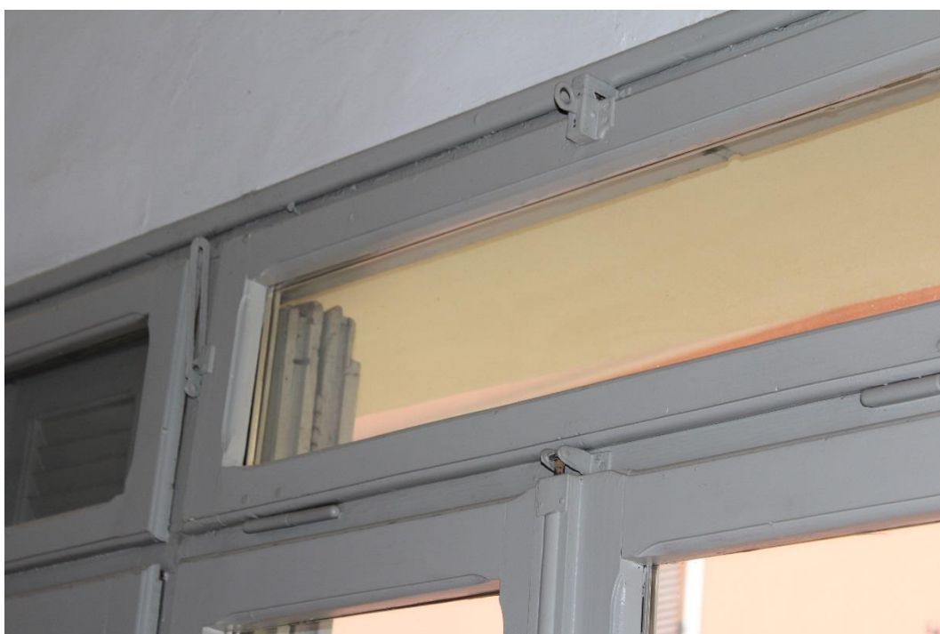
Particolare di serramento con persiane
