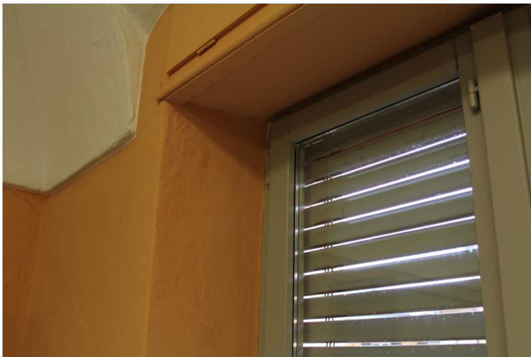
Particolare di serramento con cassonetto alloggiamento tapparelle
