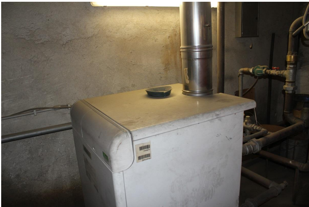
Caldia tradizionale presente in centrale termica
