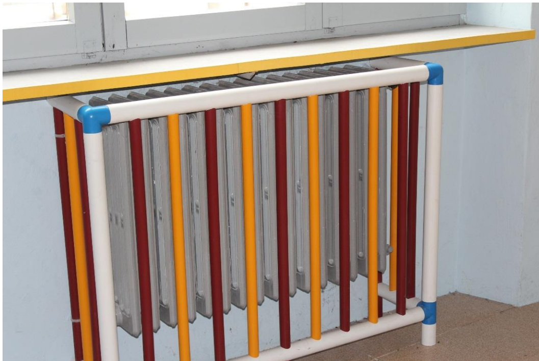
Tipologia di corpo scaldante presente nell'edificio
